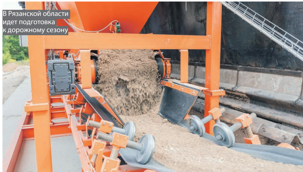
В Милославском районе идут дорожные работы в рамках реализации проекта «Безопасные качественные дороги»
